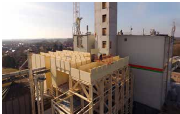
Монтаж гладкостенных силосов | GRP Silo system during assembly
