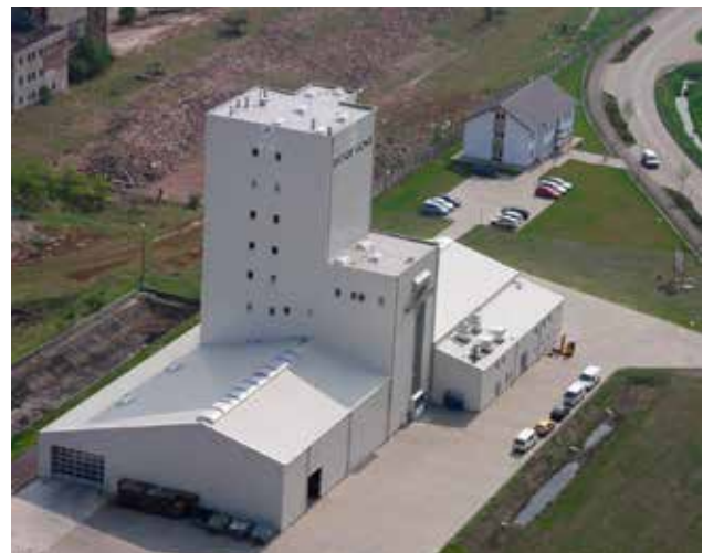
Завод по производству премиксов и минеральных смесей, Хальдеслебен, Германия | Premix and mineral feed plant in Haldensleben, Germany
