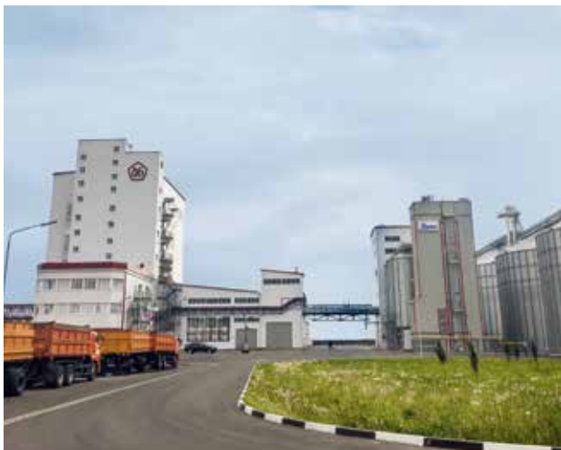
Комбикормовый завод 30 т/ч, Белгородская обл., Россия Compound feed plant 30 t/h in Belgorod area, Russia
