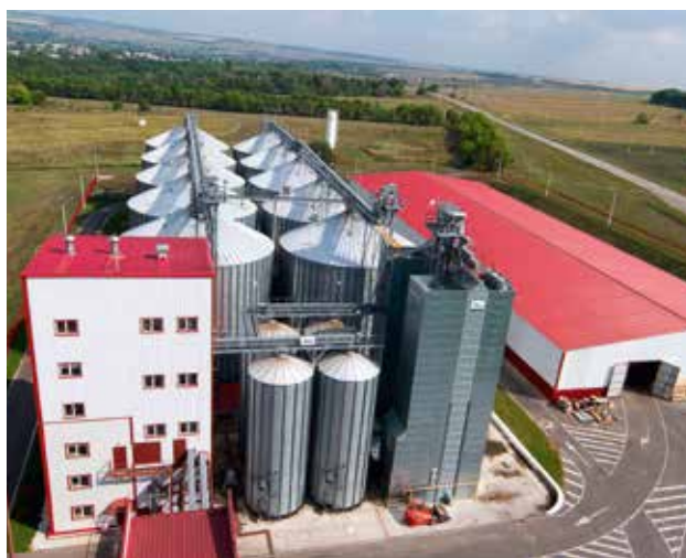
Зернохранилище 30.000 т с очисткой и сушкой, Белгородская обл., Россия Grain storage 30,000 t with cleaning and drying in Belgorod area, Russia
