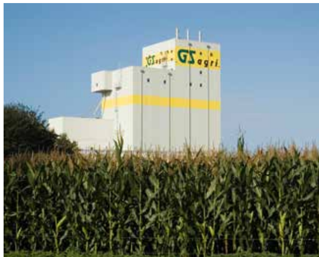
Комбикормовый завод 265.000 т/г, Гаррель, Германия Compound feed plant 265,000 t/a in Garrel, Germany
