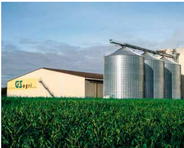
Зернохранилище 3 x 4.000 т, Шнайдеркруг, Германия Storage bin system 3 x 4,000 t in Schneiderkrug, Germany
